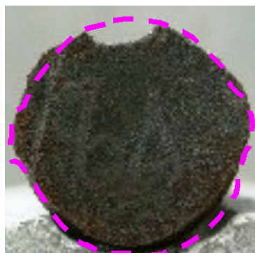
图3 除去锈蚀产物后的内部钢筋
