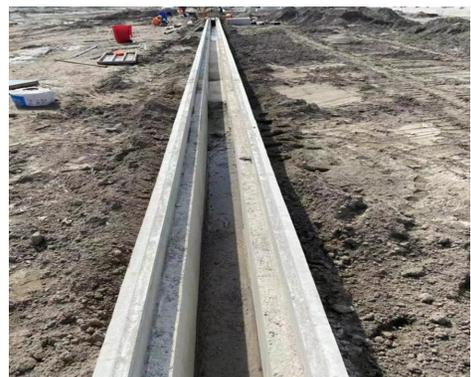
图 4 排水沟混凝土浇筑表现质量
