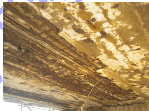
a) 现场检测
