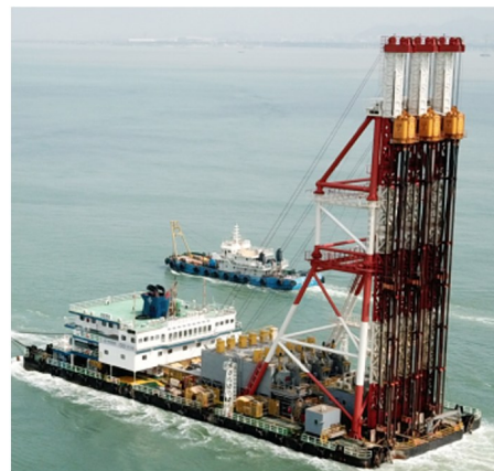
a) DCM 施工船整体
