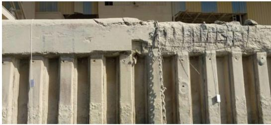
图 10 1968 年胸墙混凝土结构表现
