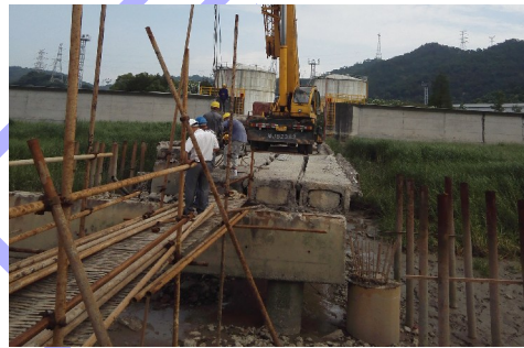
图 1 码头引桥空心梁板拆除现场
