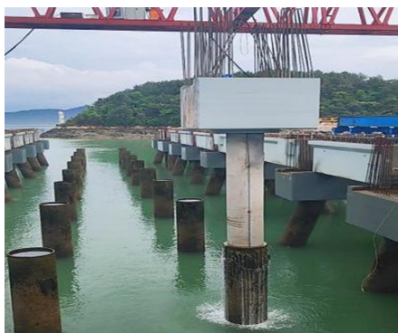
c) 吊装施工
