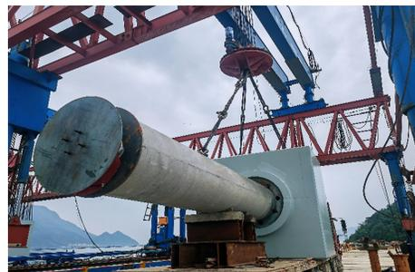
图 4 钢栈桥上起吊
