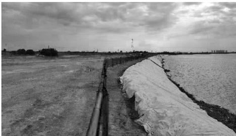
图 3 筑岛填土施工
