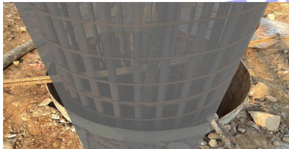
图 11 灌注桩现场校核
