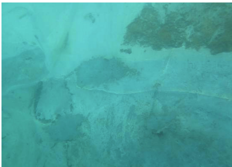
图5 沉箱水下修复后状况
