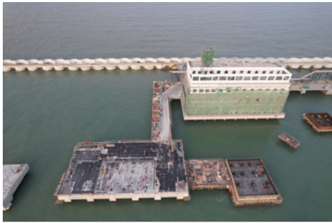
a) 现场施工
