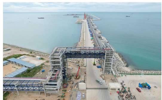
图 3 净空 18 m 跨路桁架
