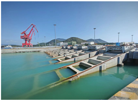
图5 已完成施工的滑道
