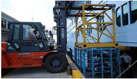
图 7 行李舱口位于码头面以下装卸作业
