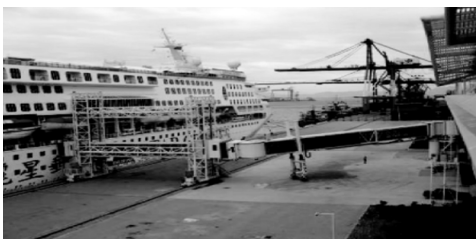
图5 厦门港国际邮轮中心组合式登船桥方案
