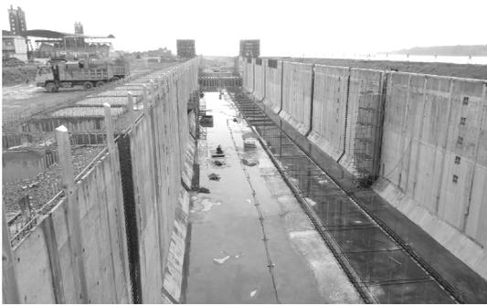
图8 小溪滩船闸闸墙施工效果
