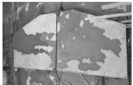
图 7 小溪滩船闸门坎浇筑后未见任何裂缝
