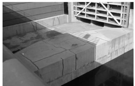
图 6 红船豆船闸门坎混凝土裂缝
