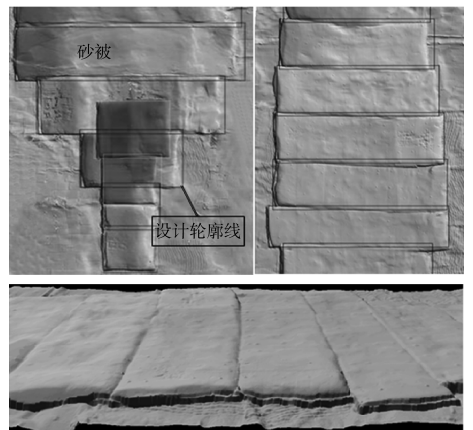
图 14 砂被铺设质量检测
