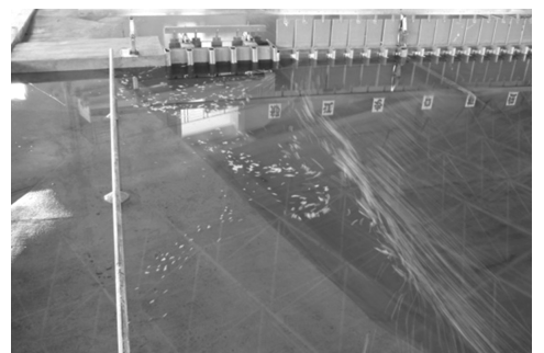
图3 枢纽敞泄电站上游回流
