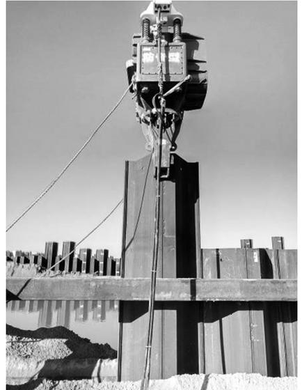
图 5 锚桩初沉现场施工
