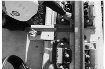
b) 用轨道作为一条直角参考边,用直角尺标出磁钉的中心线以及轨道上的直角点
