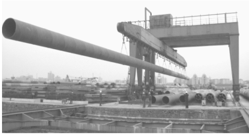
b) 现场吊桩
