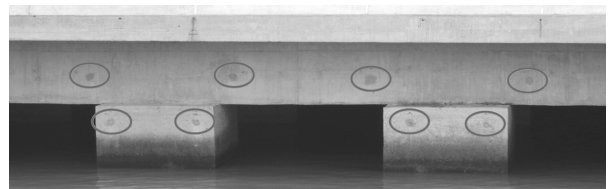
注: 划圈为修补后的孔洞
