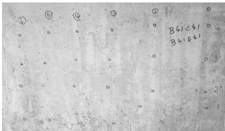
图3 钢筋网格实际测点布置
