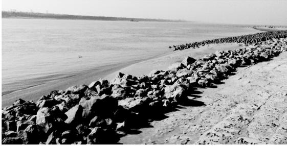
图6 已建 YR1 护滩带右缘
