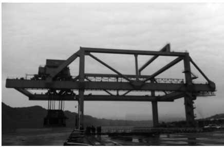
图4 悬臂式钢结构基础的双跨桥吊
