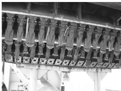
图4 B施工区施工后改进的耙齿安装情况
