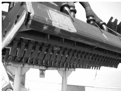
图3 B施工区施工前耙齿安装情况
