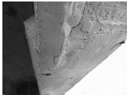
图9 人行桥裂缝
