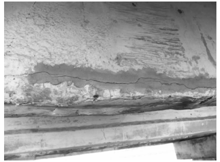
图8 引桥裂缝
