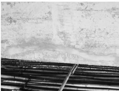
图5 引桥裂缝修补
