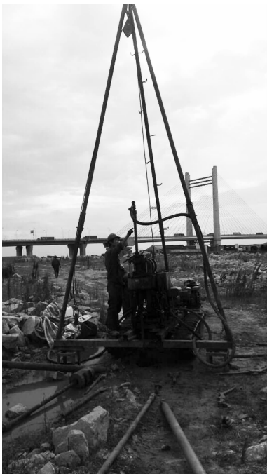
图1 常规百米钻+岩芯管钻进工艺
