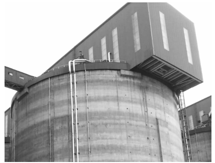
图8 仓顶取消环梁做法
