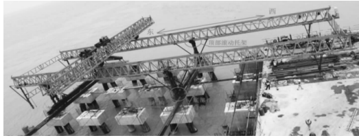
图 7 吊装机过孔完成
