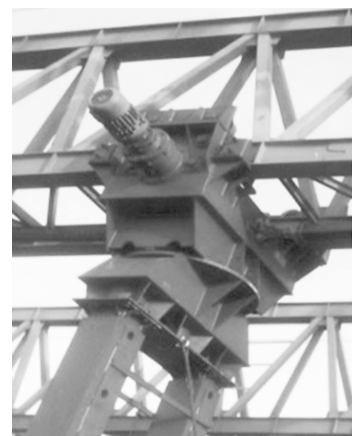
图3 支腿顶部滚动托架
