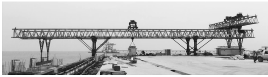
图10 配重、辅助支腿及面层浇筑
