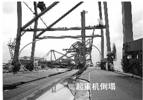
图1 起重机整体倒塌（六甲 Island 地区）
