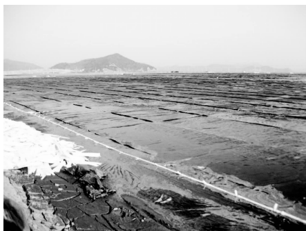
图2 编织布铺设完成及主滤管铺设施工
