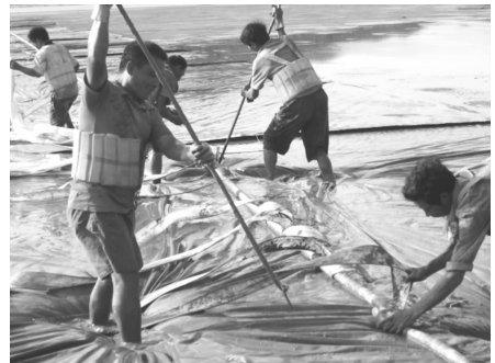
图3 人工插打排水板
