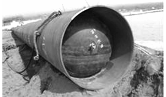
图4 气囊安装
