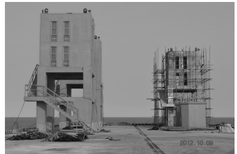
图 4 上部结构陆上整体预制
