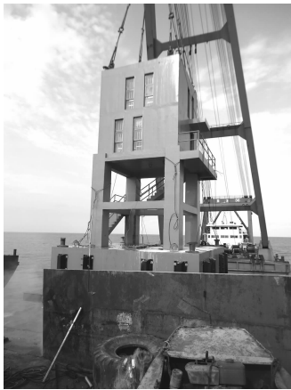
图6 观测室海上安装
