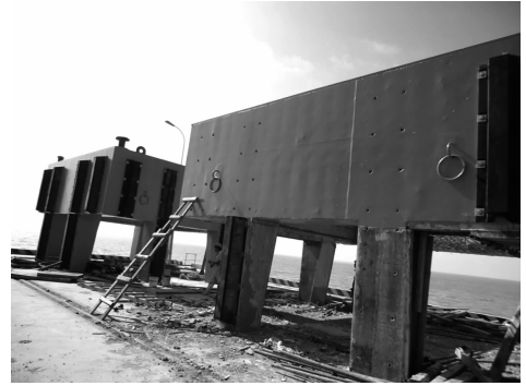
图 3 墩台预制部分陆上整体预制
