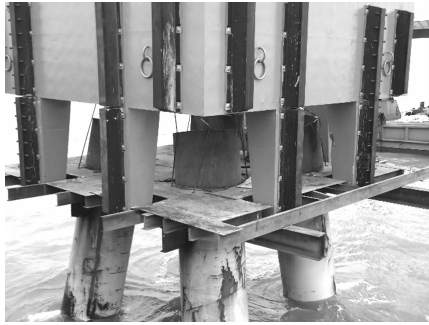
图5 墩台预制部分海上安装
