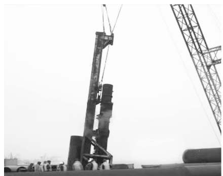
图6 柴油锤吊打斜桩
