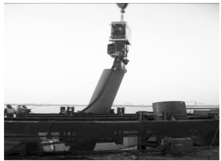
图5 振动锤施打斜桩
