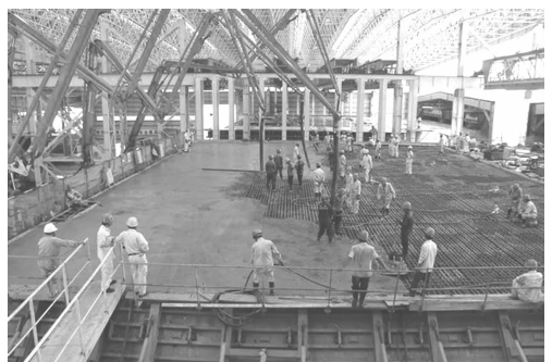
图9 泵送混凝土全断面浇筑
