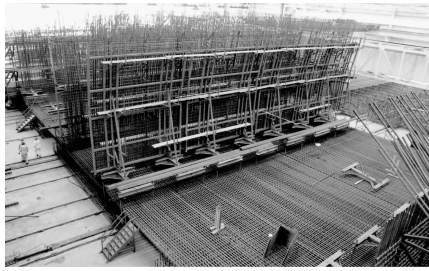
b) 侧墙钢筋绑扎
