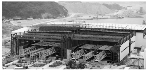
图8 带针形梁支撑的全断面液压模板
