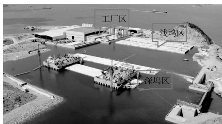
图 6 港珠澳隧道沉管预制工厂布置
