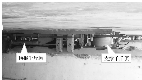
图 10 沉管分散顶推及支撑千斤顶
