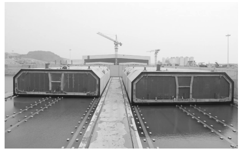
图 11 沉管脱离底模后沿滑动轨道顶推
