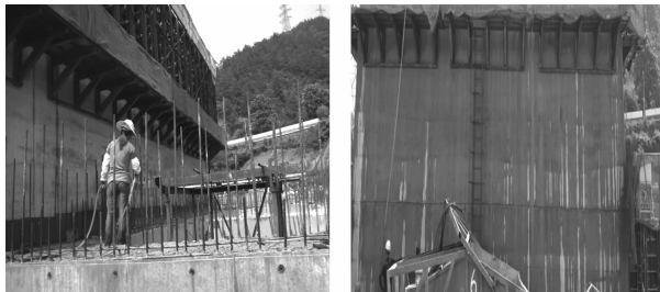
a) 夏季及常温施工期洒水养护
