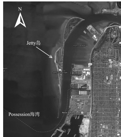
图 3 Jetty 岛利用疏浚物进行海滩养护
