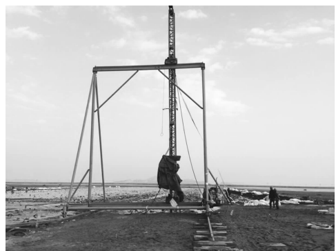
图2 打设排水板
