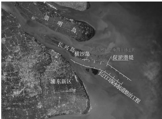
图2 横沙东滩围垦工程
