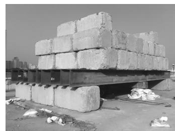
图7 码头上部堆载现场
