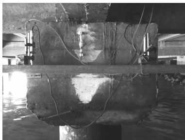
图8 码头下部测量设备安装
