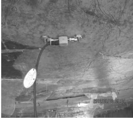
图 6 测点现场埋设情况
