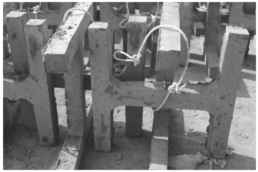
图 1 组装成型的扭双工字型透水框架
