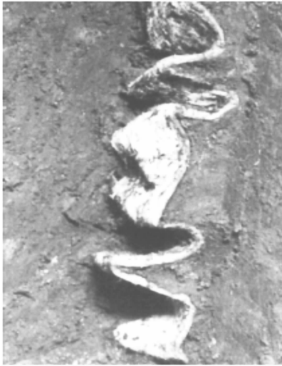
图 2 地基处理后的排水板形状
