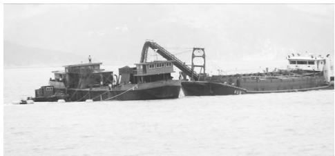
图2 皮带砂船吹填作业
