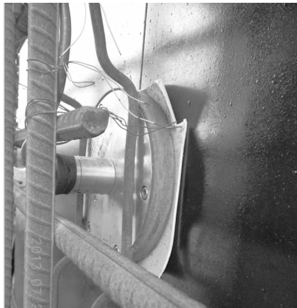
图4 土压力计的安装
