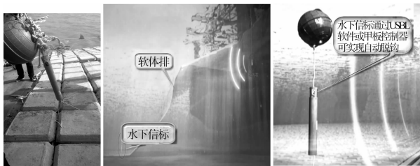
图 6 信标安装及超短基线水下定位系统工作状态
