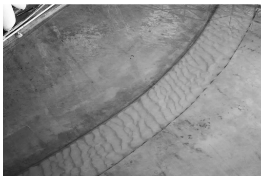
图7 20 a一遇洪水过后的挡沙槛处泥沙淤积情况
