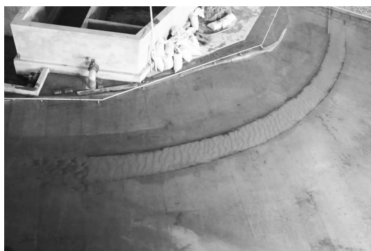
图12 20 a一遇洪水过后的挡沙槛处砂砾淤积地貌
