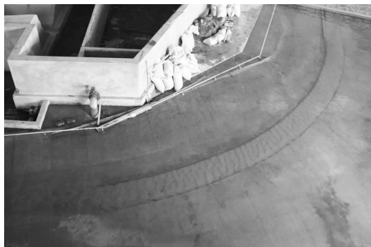
图 8 50 a 一遇洪水过后的河床地貌及泥沙淤积全景
