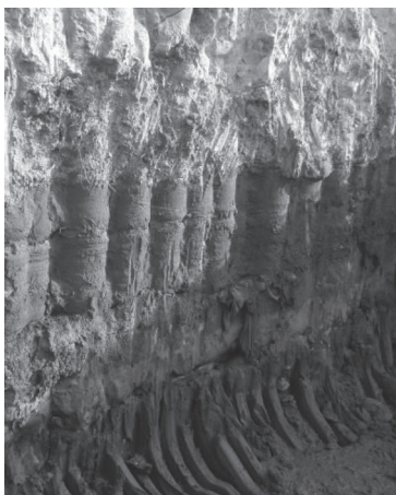
图8 基坑侧壁水泥搅拌桩成桩实体
