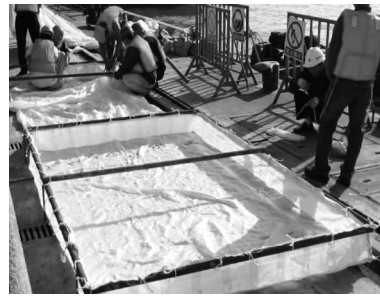
图6 土工模袋加工及固定在模袋架上
