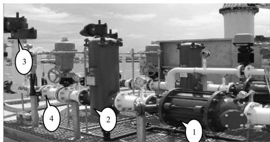
1. 阻爆器; 2. 过滤器; 3. 压力真空阀; 4. 调节阀
